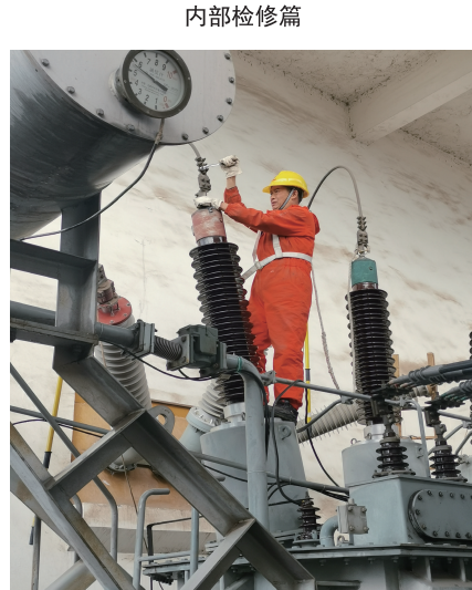
达州公司电仪部检修人员袁科国、赵益勇、李晓华等在办理好第一种工作票并设备停电后，对1#、2#主变进行检修。
