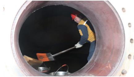
生产部尿素人员熊念等几人在办理好受限空间作业证，做好各项安全措施的情况下进入尿素尿液槽TK-101中打扫卫生。
